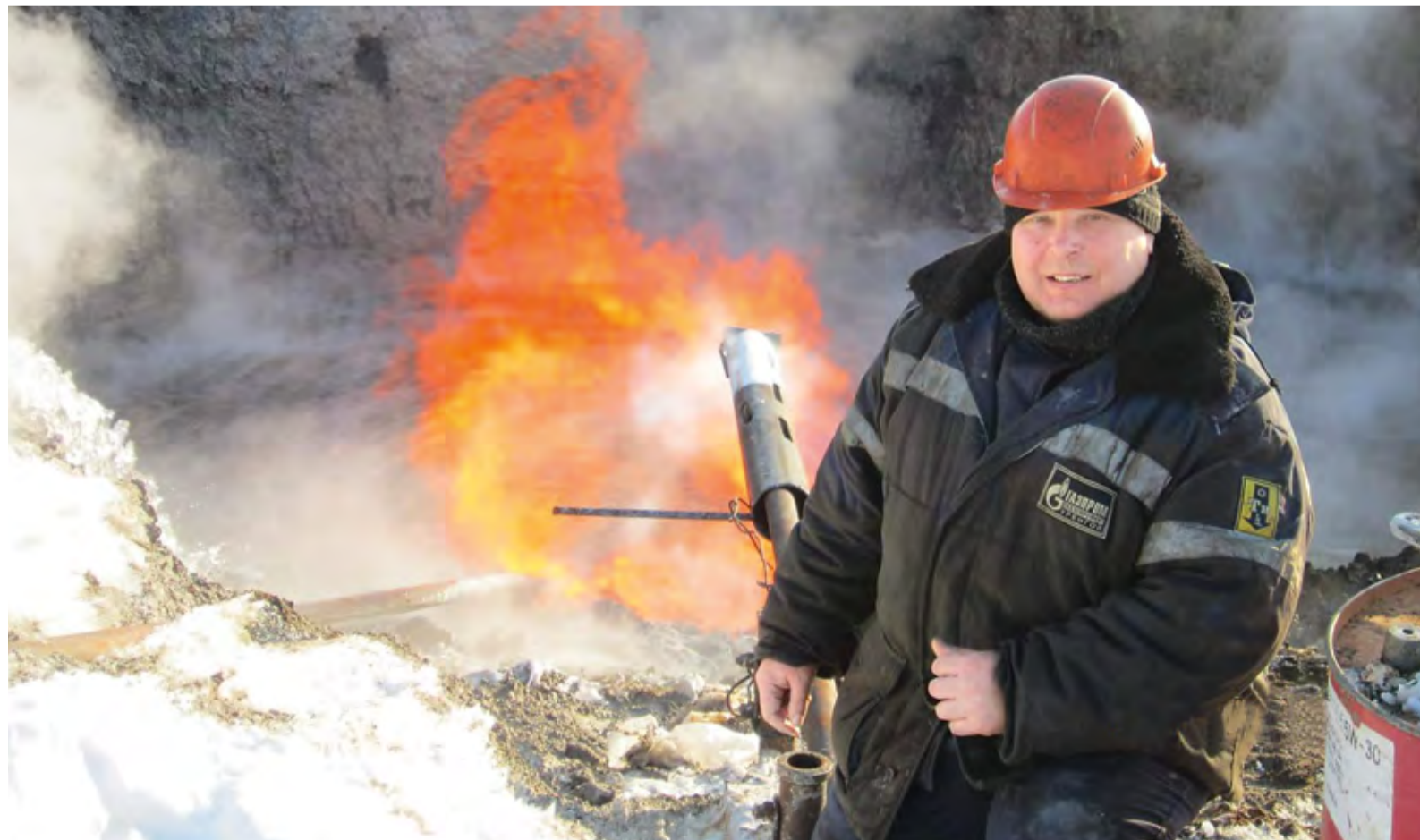
Во время испытания скважины
