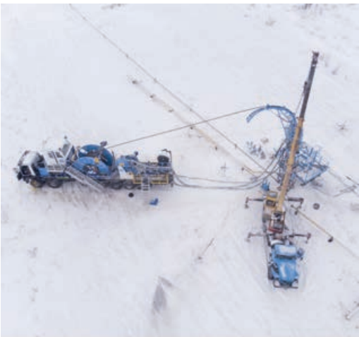
Идёт операция по спуску в газовую скважину концентрической лифтовой колонны
