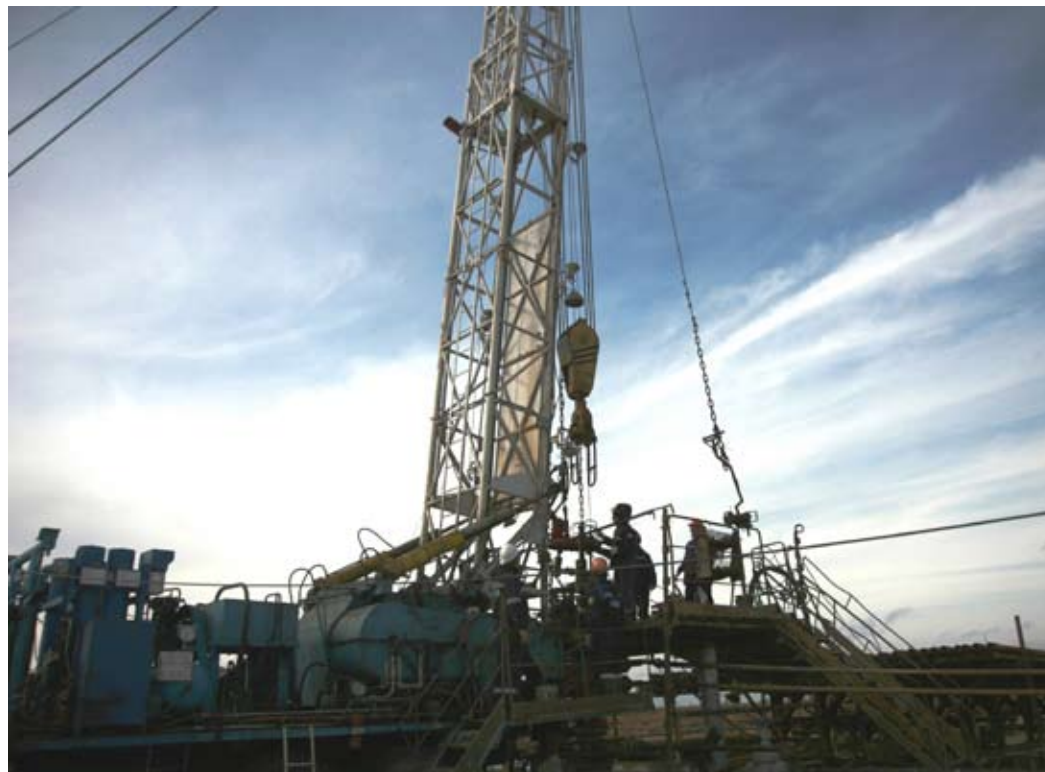
Бригада выполняет очередную операцию с помощью подъемной установки УПА-60
