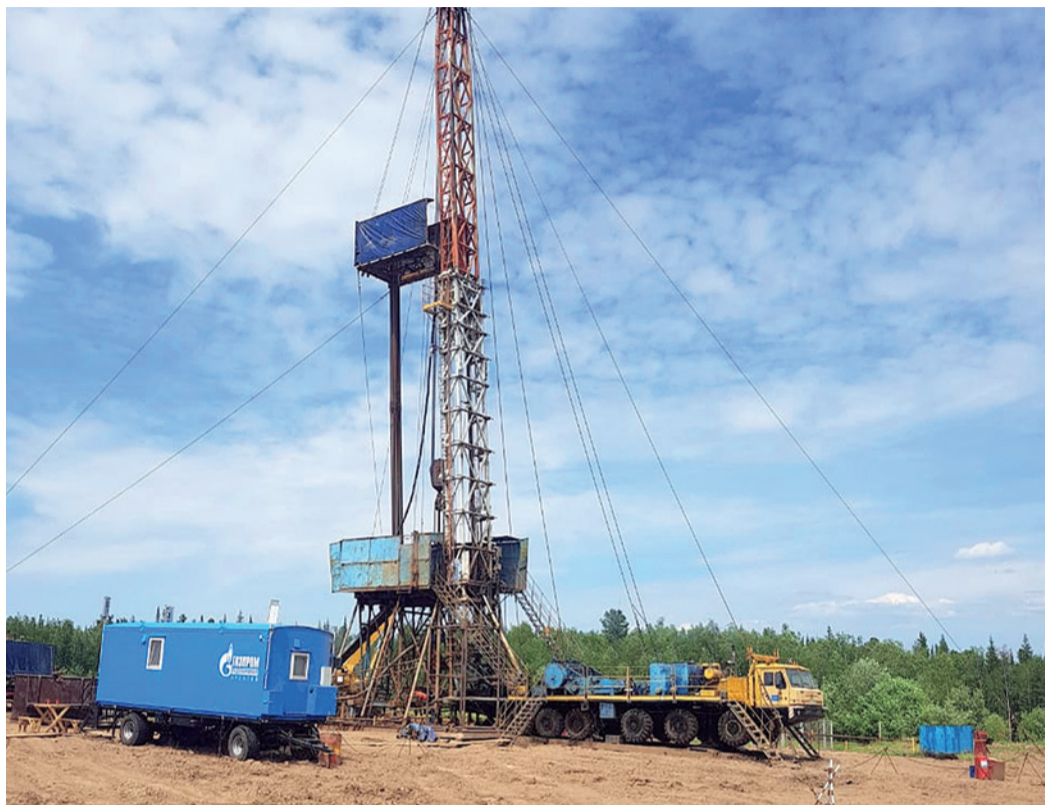
Скважина, где ведутся работы, расположена в отдалении от жилья и дорог
