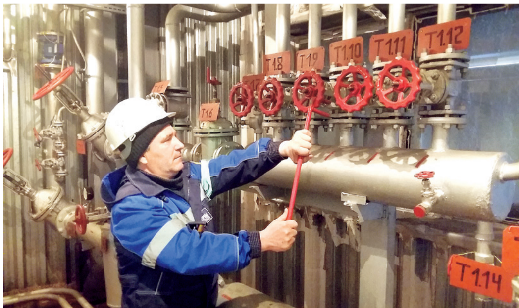
Слесарь-сантехник 5-го разряда Петр Иванович Савкин проводит осмотр теплоула
