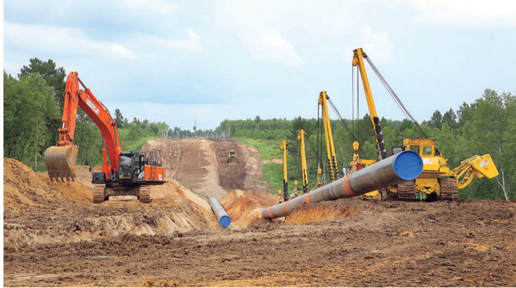
Набирает темп строительство «Силы Сибири» — газопровода в Китайскую Народную Республику
