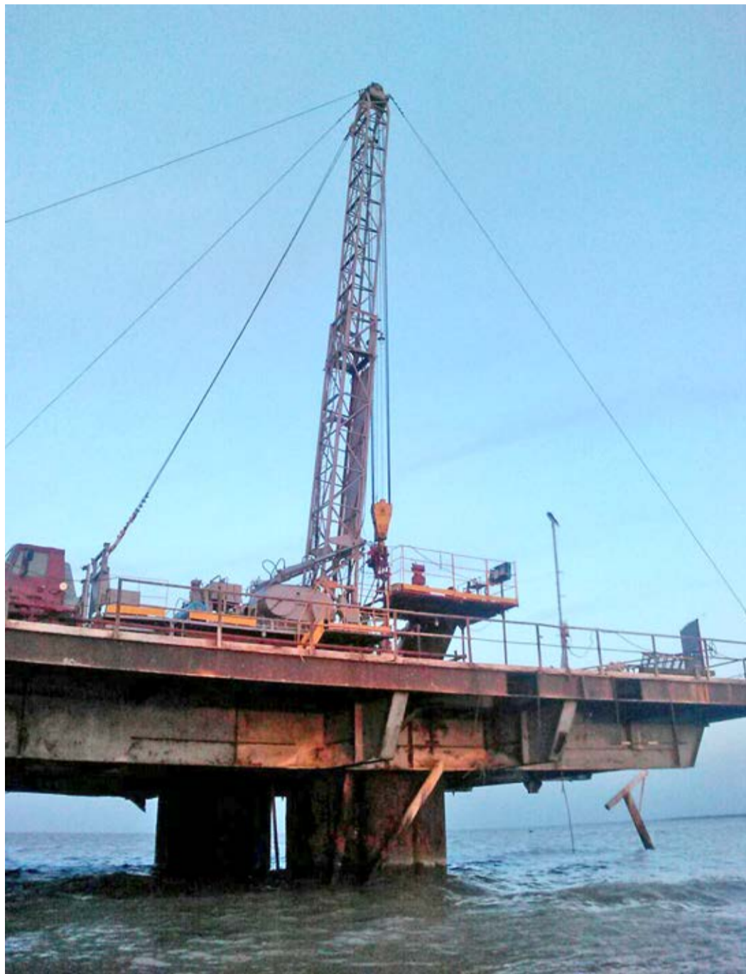
Во время проведения работ на скважине в Бейсугском лимане Азовского моря
