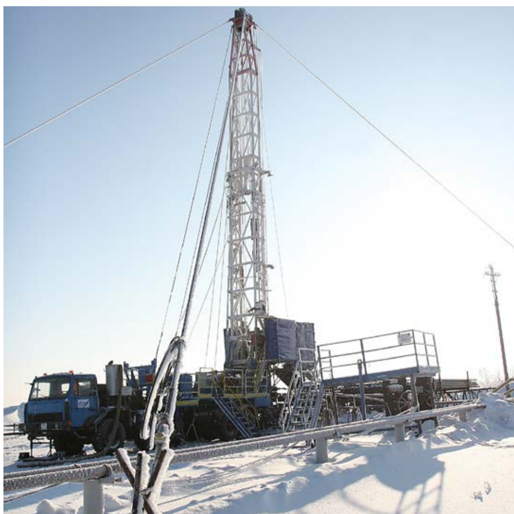
За девять месяцев 2018 года на месторождениях ООО «Газпром добыча Ямбург» завершены работы на 45 скважинах, из них на 27 скважинах – с использованием подъемных установок
