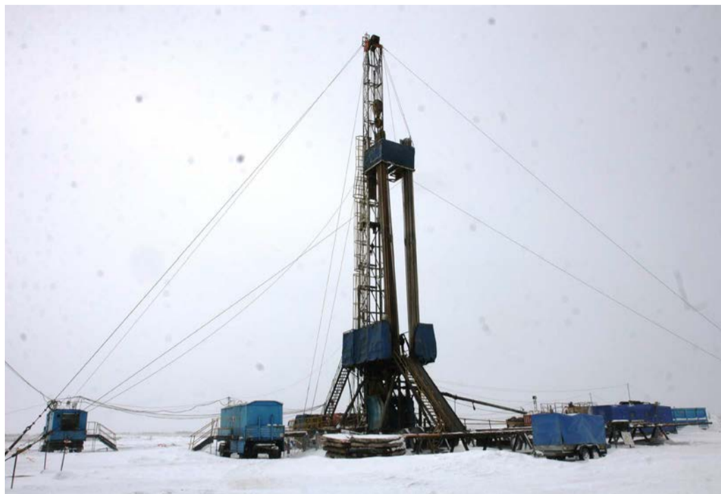
Будни бригады капитального ремонта скважин на Оренбургском нефтегазоконденсатном месторождении
