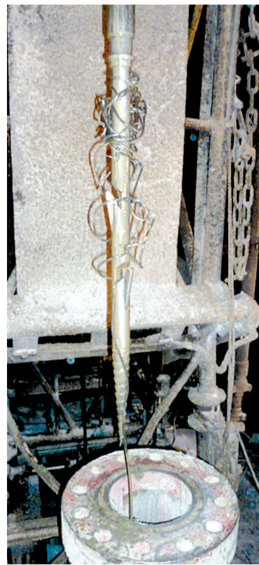
Идут восстановительные работы на Ямбургском месторождении – из скважины необходимо извлечь 1700 метров кабеля, оставшегося там после обрыва
