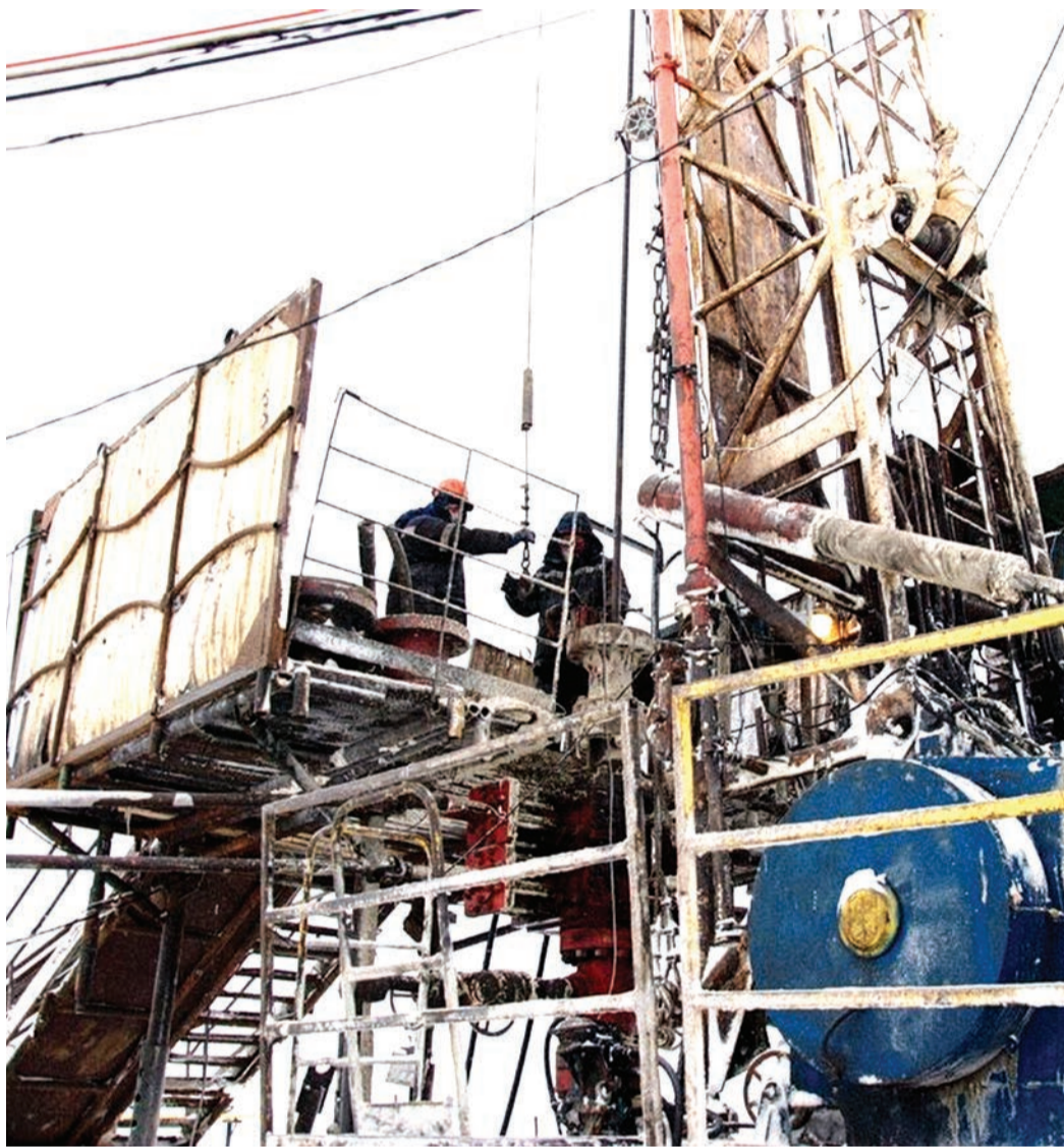
Идут восстановительные работы на Ямбургском месторождении – из скважины необходимо извлечь 1700 метров кабеля, оставшегося там после обрыва
