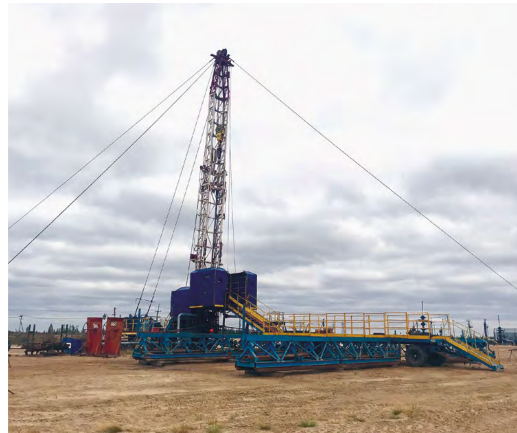
Подъемная установка готова приступить к работе на очередной нефтяной скважине
