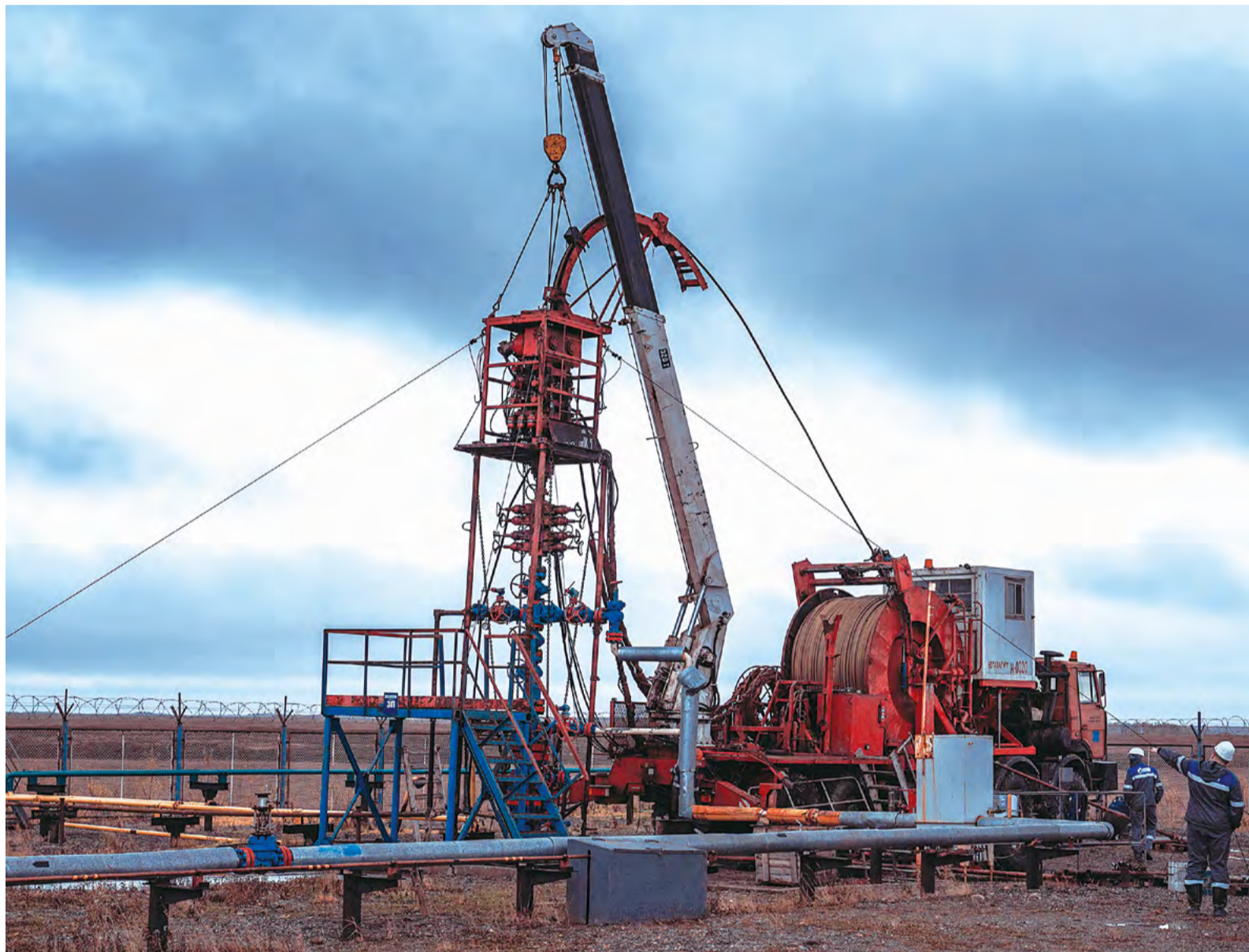
Ремонт скважины на Киукомском месторождении на полуострове Камчатка при помощи колтюбинговой установки М-20 ведут специалисты Ноябрьского УИРС
