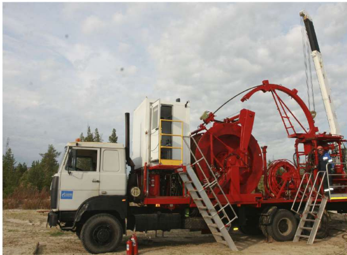
Ремонт скважины на Камчатском месторождении в Ямало-Ненецком автономном округе
