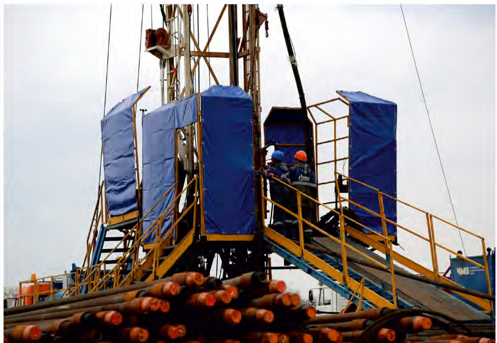
Бригада капитального ремонта скважины проводит сложную операцию
