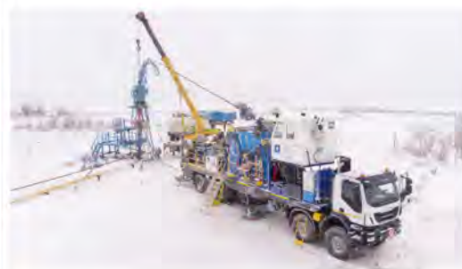
КАПИТАЛЬНЫЙ РЕМОНТ Производственная хроника
