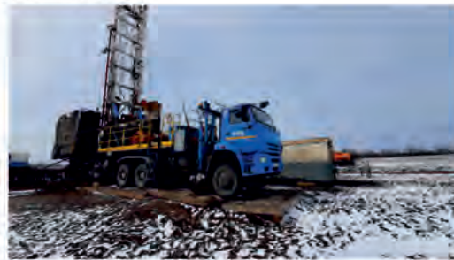
Бригада Краснодарского УИРС ведет работы по извлечению подземного оборудования
