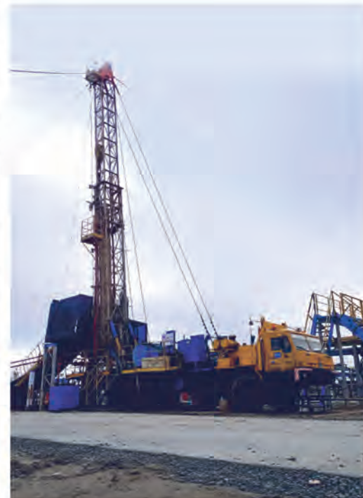
Бригады капитального ремонта скважин в летние месяцы стараются сделать максимальный задел для выполнения производственной программы
