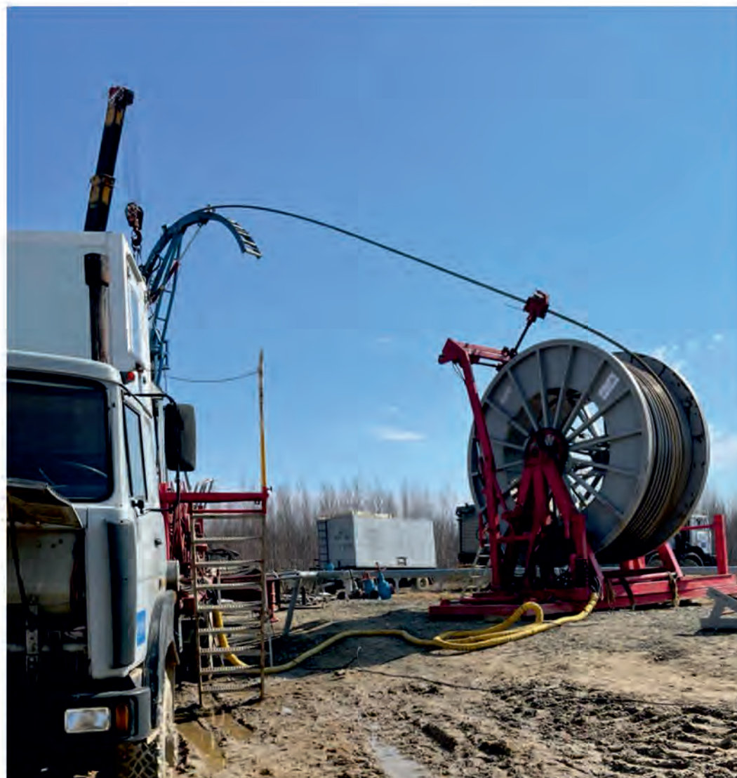
На Медвежьем месторождении проходят операции по реконструкции скважины
