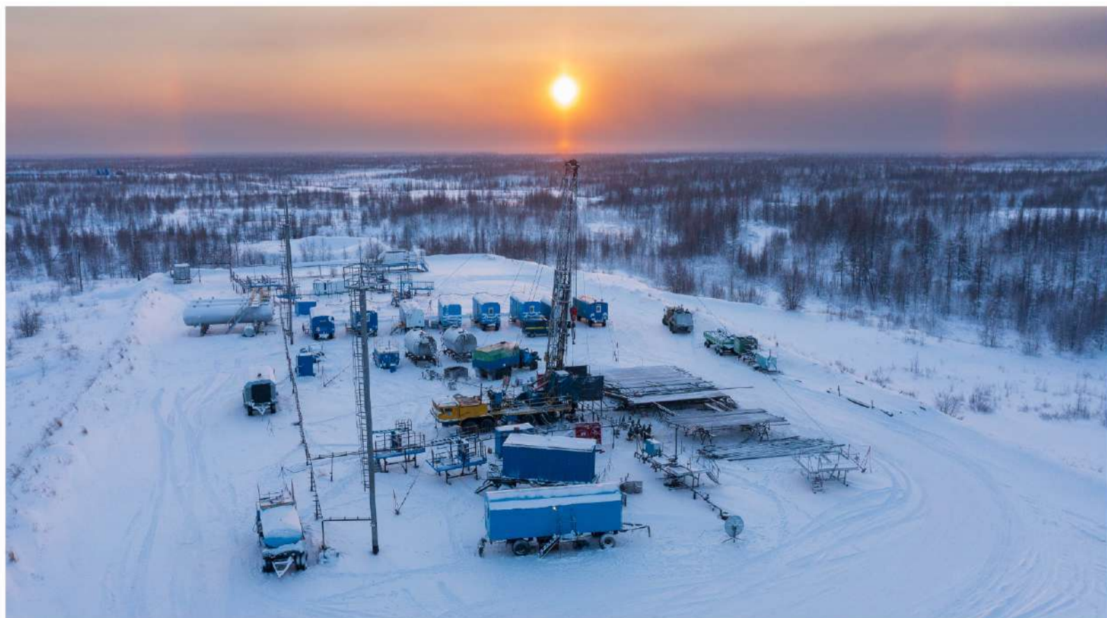
Специалисты Уренбургского УИРС ведут ремонт скважины в тридцатиградусный мороз
