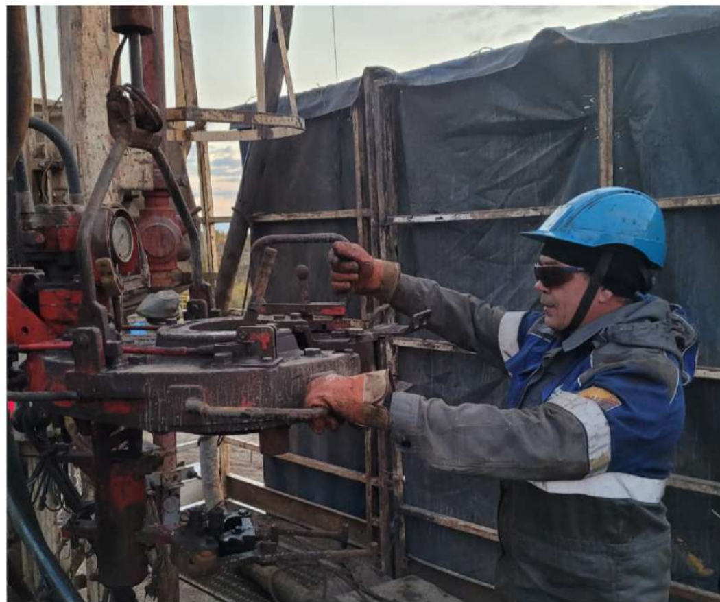
Работы на скважине № 6 протекали в непростых условиях, но были успешно завершены
