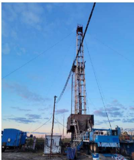
Тяжелая подъемная установка «Кремко-100» на технологической площадке скважины № 6 Тевризского месторождения
