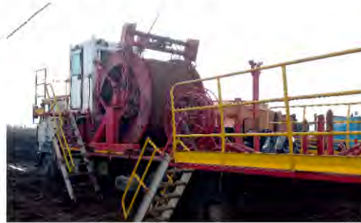
Бригада КРС-2 Краснодарского УИРС ведет работы на скважине Прибрежного месторождения
