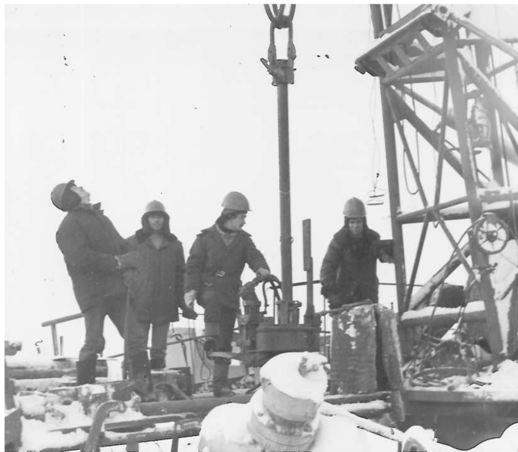
Крайний Север, Западная Сибирь. Идет ремонт скважины. 1980-е годы
