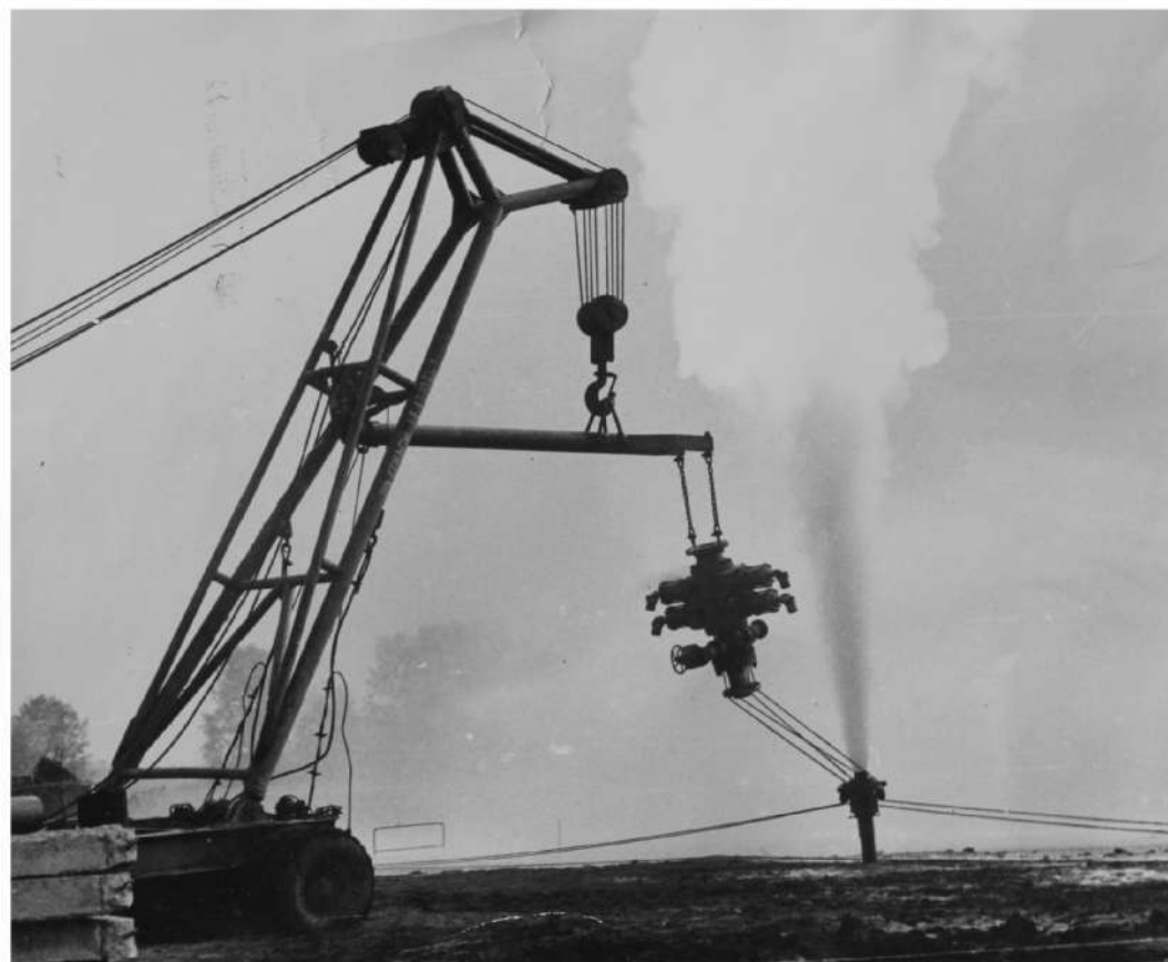
Работы на скважине идут на Оренбургском нефтегазоконденсатном месторождении. 1970-е годы.
