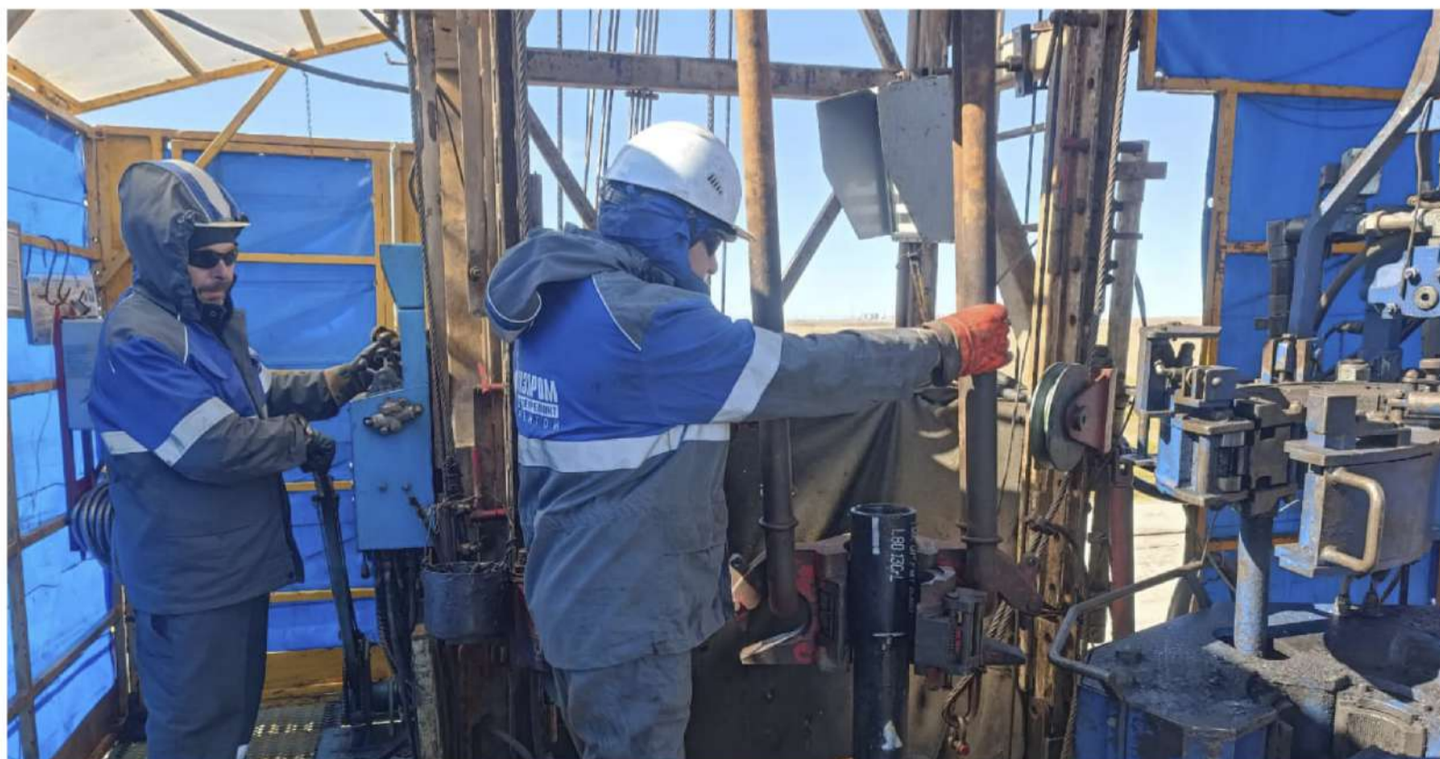
Бригады капитального ремонта скважин Надымского филиала первыми оснащены комплексами видеонаблюдения
