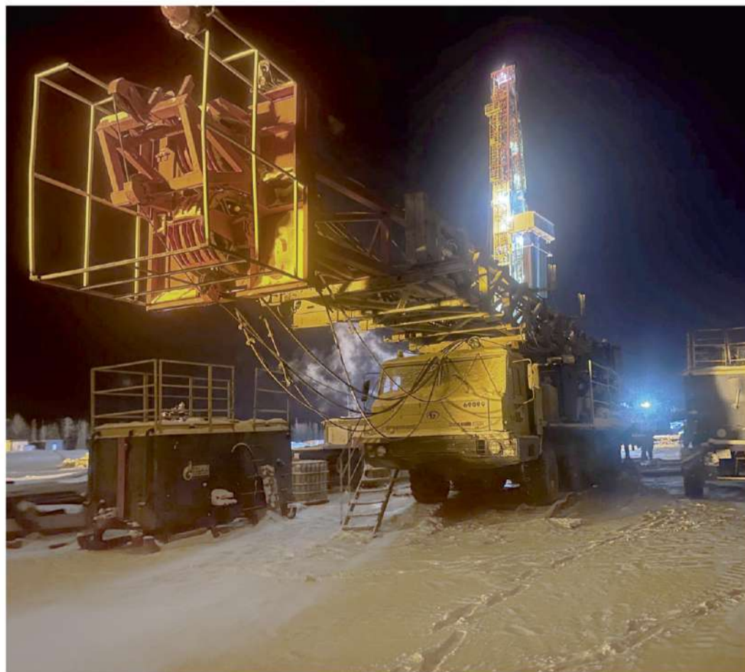
Бригады капитального ремонта скважин трудятся в круглосуточном режиме
